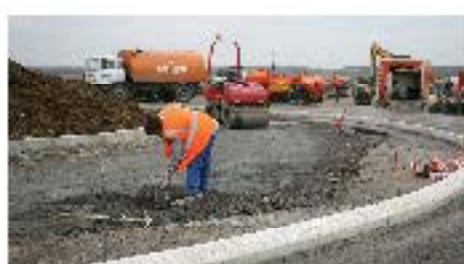
Création, aménagement et entretien de la voirie communautaire
