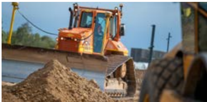
Terrassement de la patinoire
