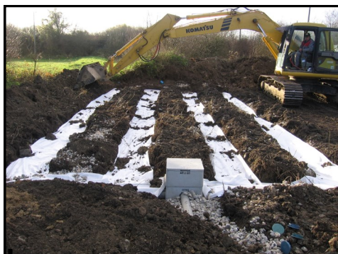
Ouvrage d'assainissement non collectif
