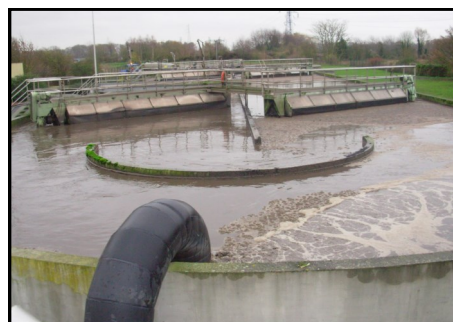
Usine d'épuration de Sin-le-Noble
