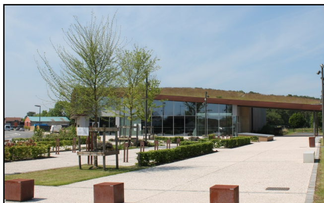
Exemple de gestion durable des eaux pluviales sur Arkéos : noues, pavés poreux et toiture végétale !
