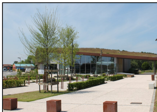
Exemple de gestion durable des eaux pluviales sur Arkéos : noues, pavés poreux et toiture végétale !
