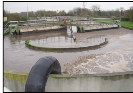
Usine d'épuration de Sin-le-Noble
