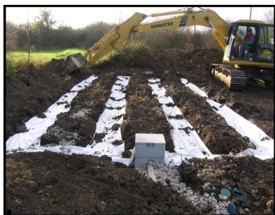
Ouvrage d'assainissement non collectif
