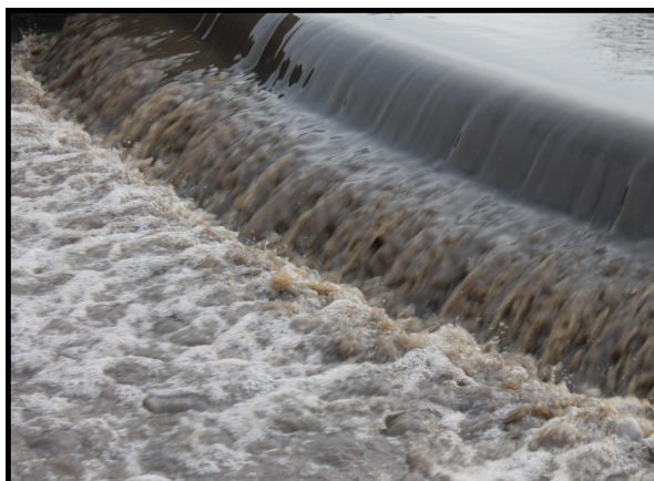
Optimisation des STEP via le diagnostic permanent
