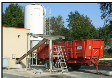
Extraction des boues STEP Sin le Noble
