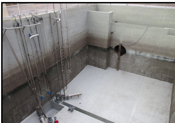
Bassin de stockage eaux usées de temps de pluie à Cantin
