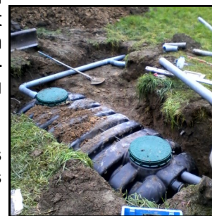
Renouvellement FTE à Lambres
