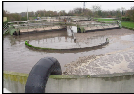
Usine d'épuration de Sin-le-Noble
